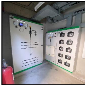
ภาพที่ 2.1-11 ระบบจ่ายไฟฟ้าของอาคาร
