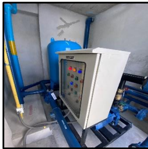
ภาพที่ 2.1-18 ระบบจ่ายน้ำประปาชั้นคาดฟ้า
